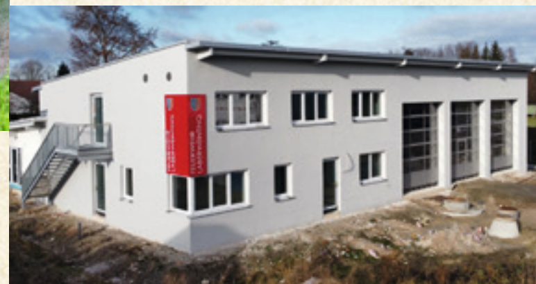
Das neue Feuerwehrhaus im April 2024. Der Waschplatz und die Außenanlagen befinden sich gerade im Bau.
