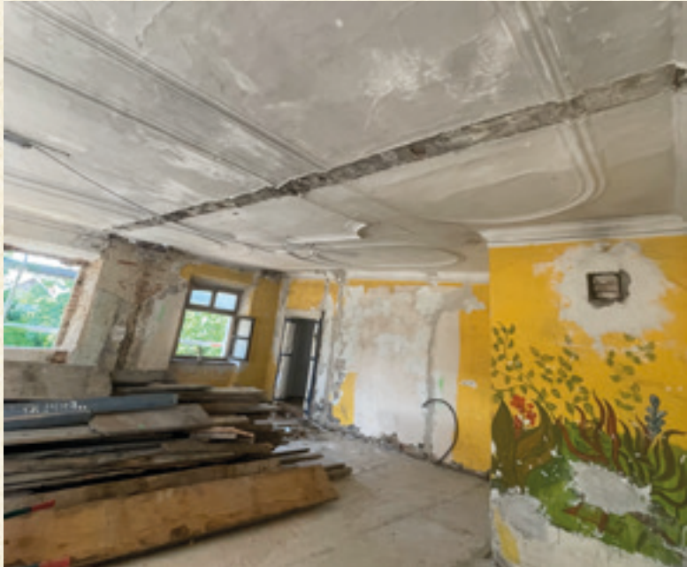
Ein Raum, der nachträglich durch eine Mauer getrennt worden ist, welche man jetzt wieder entfernte. Der Stuck verrät, dass es ursprünglich ein großer Raum war.
