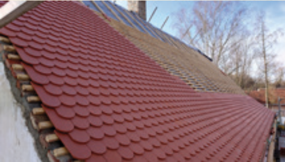
Das Dach wird mit Biberschwanztaschen eingedeckt.
