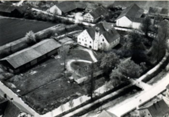
Luftbild – der ursprüngliche Schutzturm ist nicht mehr zu erkennen. Es folgen weitere kleinere Veränderungen. Der letzte Umbau ist 1970, als die Fenster erneuert werden.
