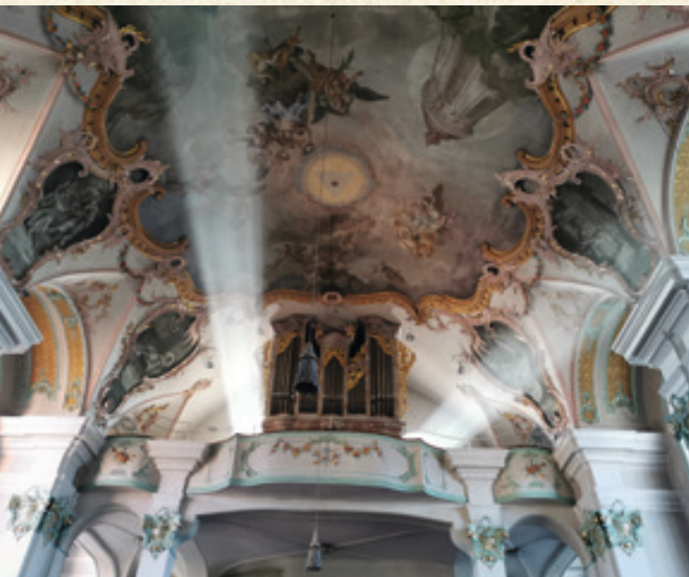
Die beiden runden Fenster in der Westfassade lassen zu den Tagundnachtgleichen einen genau berechneten Lichtstrahl ein.
