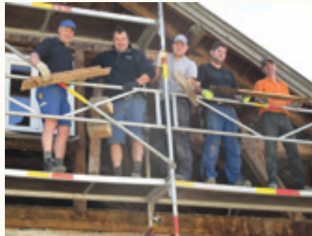
Im Frühjahr 2011 ging es an die Erneuerung des Dachstuhls.
