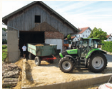
Der Keller wird aufgeschüttet.
