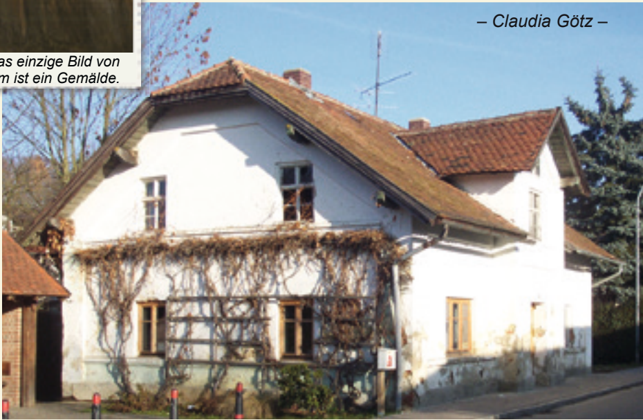
Das ehemalige Haus Kajetan Kärlingers in der Marktstraße 18.
